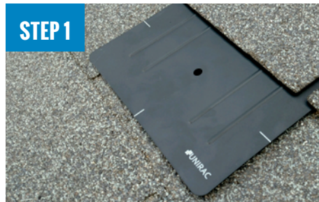
INSTALL FLASHKIT PRO FLASHING
